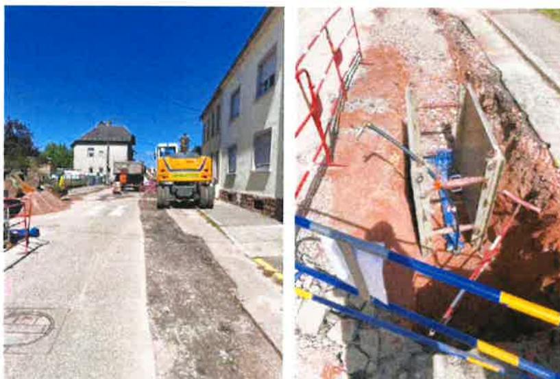
Renouvellement du réseau d'eau potable rue des Remparts
