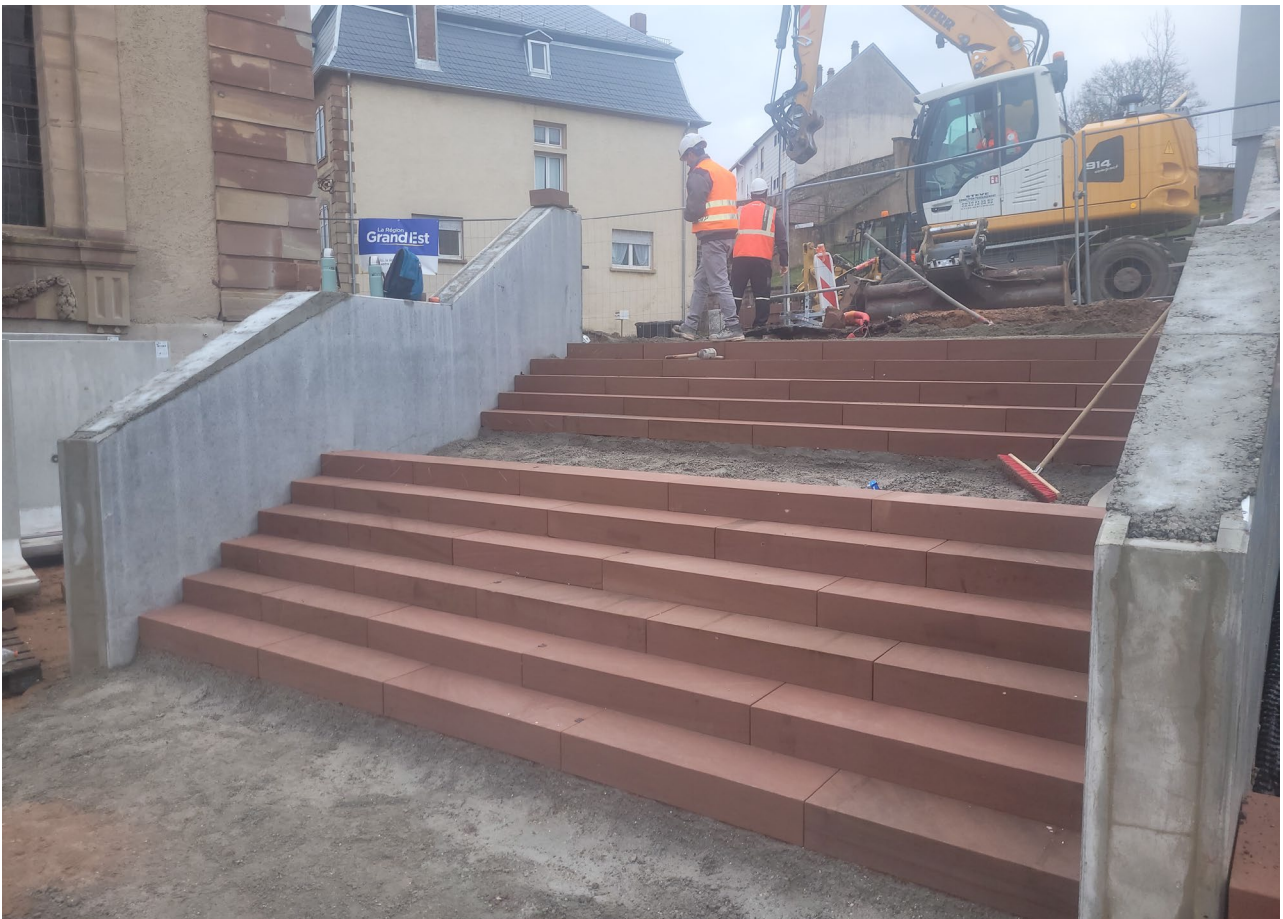
© Pose des marches en grès devant l'Eglise Sainte Catherine, Mairie de Bitche, A. Kamil, 2024
