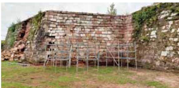
La première tranche de travaux à la citadelle s'est achevée avec la réfection du chaînage d'angle du bastion 1 et celle de la contrescarpe du fossé sec devant la grosse tête pour 145 591,37 € HT auxquels s'est ajouté un surcoût de 6 405,52 € HT en raison d'aléas de chantier.
